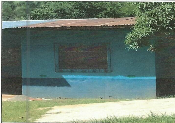
Foto 1: Mejoramiento e instalación de estructura metálica cubierta de lámina troquelada calibre 26
