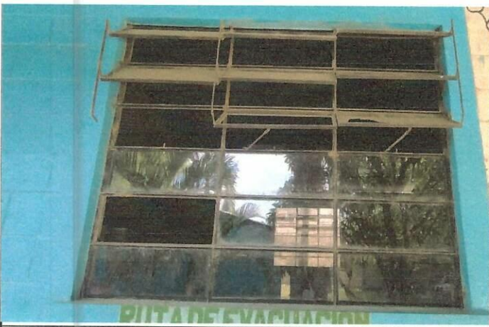
Foto 3: Mejoramiento e instalación de ventanas.
