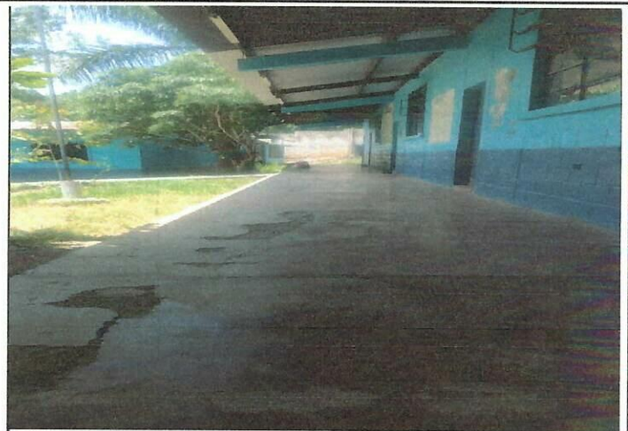
Foto 2: Mejoramiento e instalación de piso cerámico.
